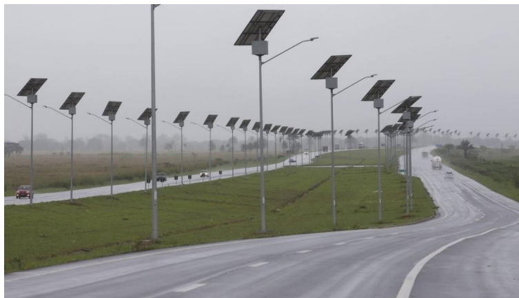
Figura 1 – Postes com placas solares no Arco Metropolitano do Estado do Rio de Janeiro
